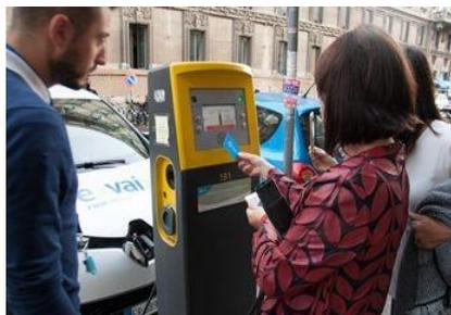
**22.** Appoggiare la **tessera blu** sul sensore della **colonnina** per permettere lo sblocco della presa di ricarica. Successivamente collegare il cavo alla presa selezionata sulla colonnina
